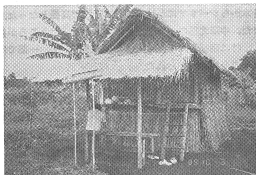
写真1 コッタバン丘陵に設置した観測小屋。階上部が観測室(電波環境測定用パソコン・スベアナ等設置)・食堂・会議室・宿泊室(定員4名)・娯楽室(ドミノ常備)・祈禱室(回教徒用)を兼用し, 階下部(土間)が梱包用機材倉庫・作業員詰所・守衛所(空気銃常備)・仮眠室(定員3名)の兼用である。なお別に厨房と自記雨量計記録器・発動発電機設置用の小屋を後方に設置し, また周囲数mの草を刈り気象観測露場・洗濯物干し場などに用い, さらに特別宿泊室としてテントも1つ立てたが, 朝方の寒さのため, 1泊しただけで後は使わなかった。その他の用は, 虎や蛇の出ないことを念じつつ, 人目につかない草むらの中で足すことになる。(M.D.Y.)
