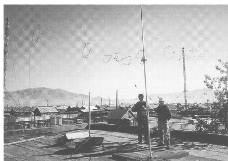
第13図 気象台屋上の高層観測アンテナ。左 GPS ゾンデ用、中央オメガゾンデ用。背景に気象無線通信の鉄塔とアンテナ。
