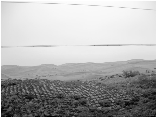
第11図 ゴビ砂漠の南端付近（砂漠内を通る道路から撮影）。写真の奥が砂漠で、手前の道路側には飛砂防止がなされている。2010年10月27日9：57に撮影。
