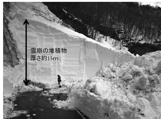
第3図 厚さ約15 mの雪崩の堆積物。2014年2月23日に山梨県甲府市古関で撮影。
