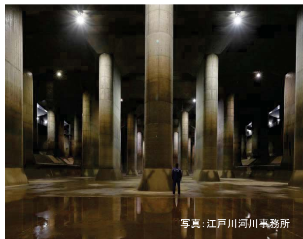
写真-4 首都圏外郭放水路庄和機場の調圧水槽
