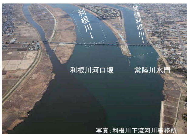
写真-3 利根川河口堰と常陸川水門 (似た外観であるが、水門は支川に設置される)
