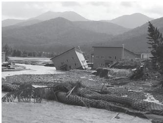
写真2: 空知川太平橋から見た破堤箇所及び流域の左岸側(9月1日に著者らが撮影)。上流の別の決壊箇所より氾濫した水(画面左奥)が, 撮影地点の堤防を決壊させ河川(画面手前)に再度流入。画面奥にはトウモロコシ, にんじん等の農地が存在。表層土が流出し, 礫層・粘土層が露出。
