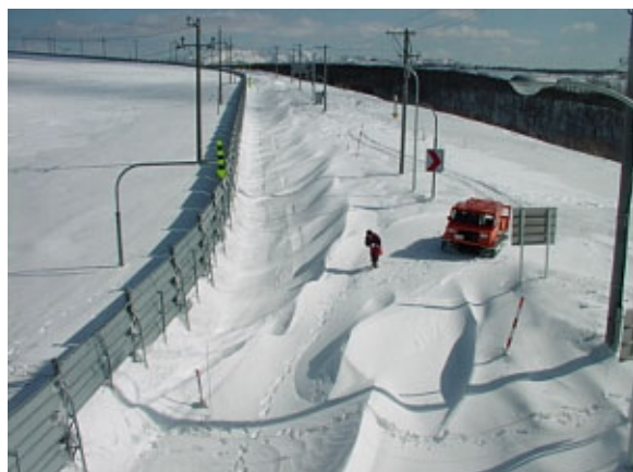
写真2 吹きだまりに埋もれた道路
