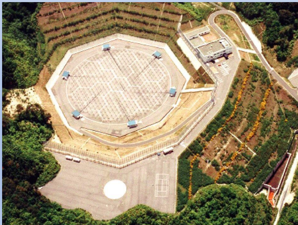
世界最大規模を誇る MURレーダー
