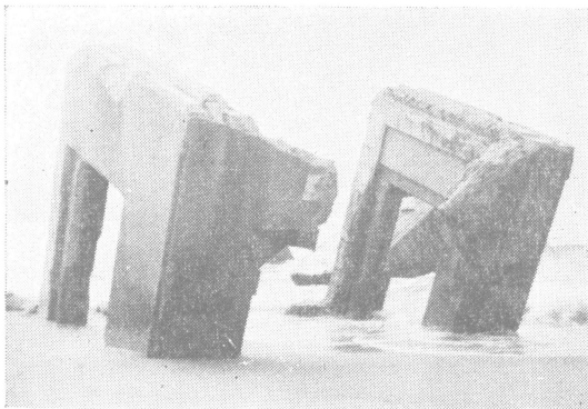
崩壊した正面玄関（昭和31年7月7日撮影）
