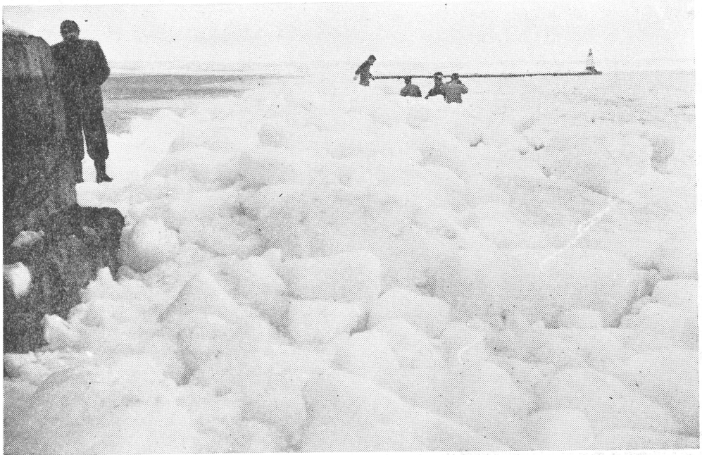
北風で防波堤に押上げられた流（Br）塊（稚内防波堤港内流氷港外離寺中）成田月昶撮影
