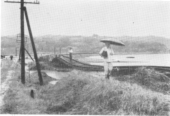
写真 2 国鉄大村線岩松駅付近、道床が流されてしまった
