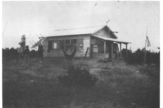
写真7 テレメーター室全景
