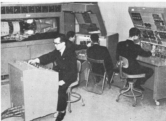
口絵 No. 2. ジェット旅客機を操縦するには最も熟練した乗員が必要である。このための訓練の第1段階としては地上で写真のようなシミュレータを用いる機内と全く同じメーターを配置して実際の飛行と同じ結果が表われるような装置である。写真は日本航空の訓練状況である。
