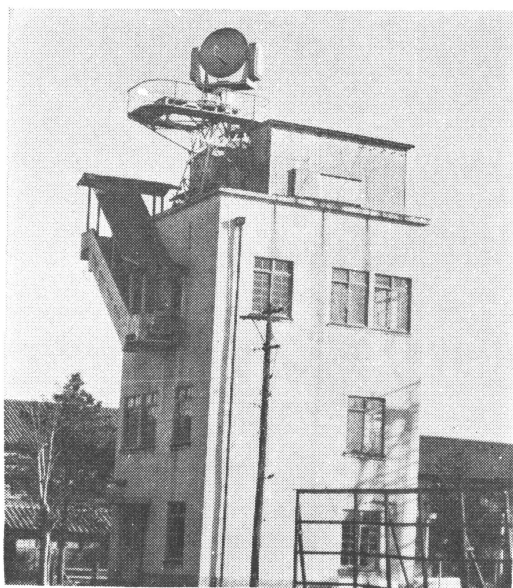
台風研究部の一部。屋上に見えるのはレーダーのアンテナ
