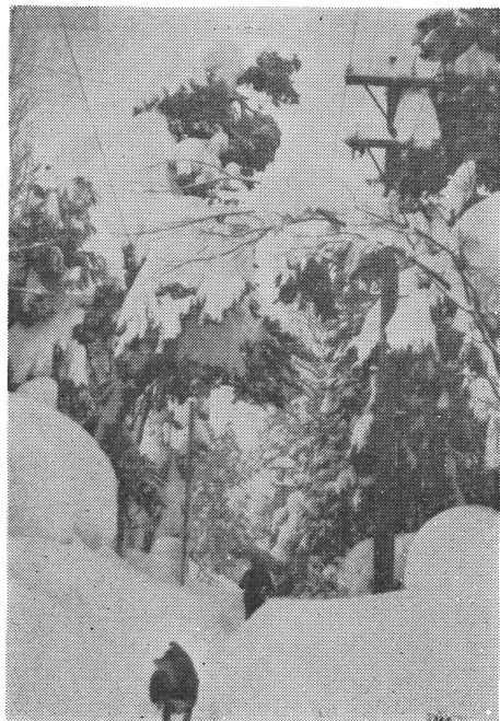
35. 12. 31. 高田変電所大町線
