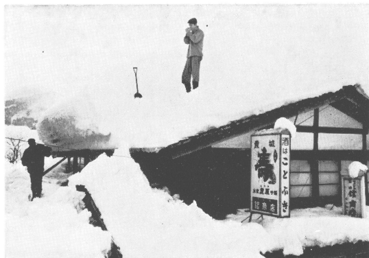
僅かのやみ間には屋根の雪おろしをしないと家が潰れる。上の人のいる所は二階屋根
