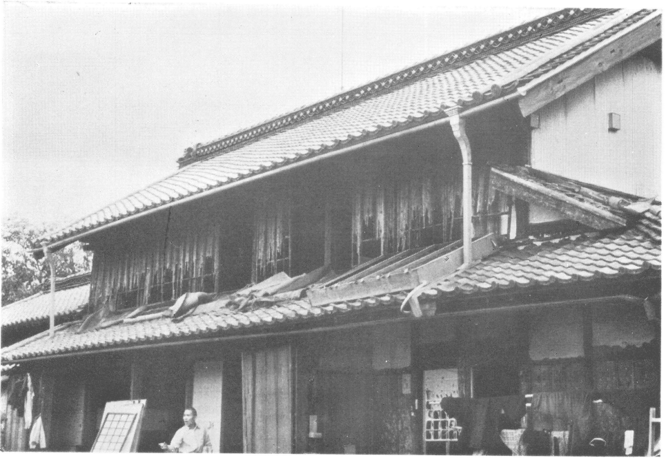
ひょうのためすだれのようなになった雨戸 (埼玉県妻沼町小島)
