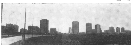
No. 40. 新しく出来つつある Novibeograd 市。
