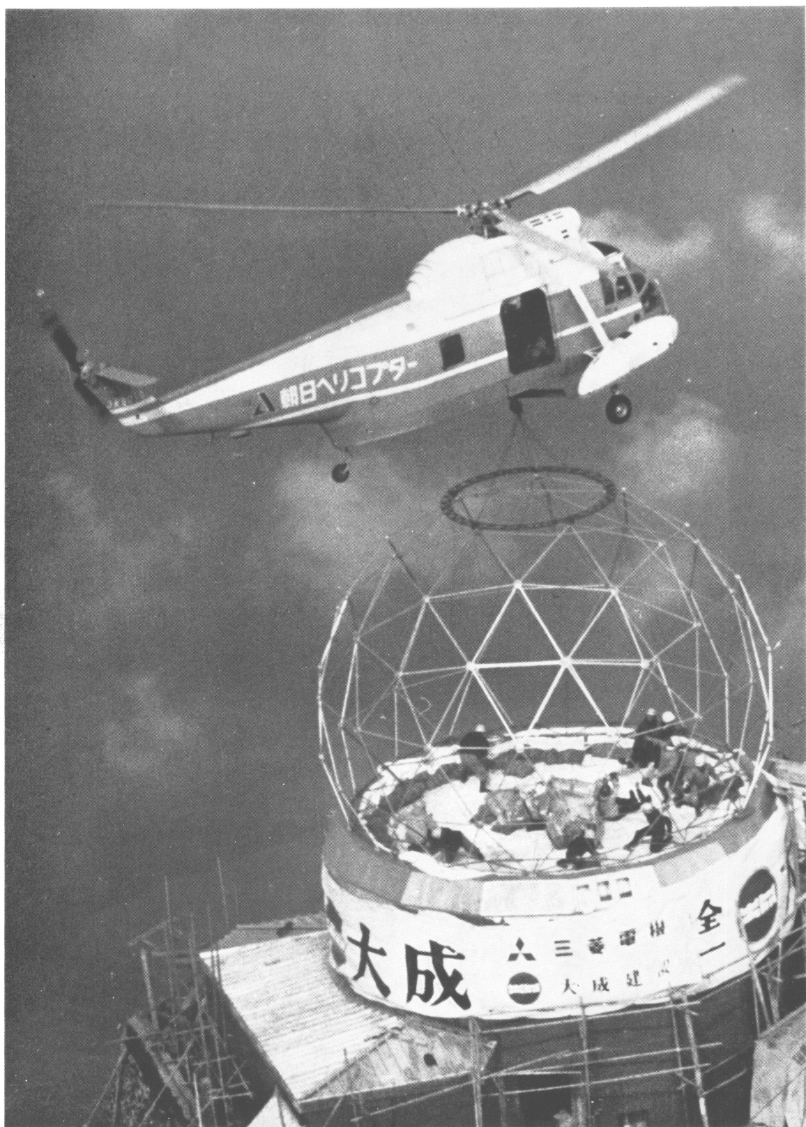
第3図 ヘリコプターによるレドーム枠つり降ろし成功 (昭和39年8月15日, 朝日ヘリコプター撮影)
