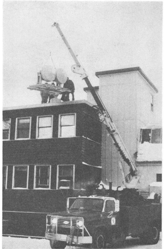
写真12 撤収中のミリ波レーダーのアンテナ。
