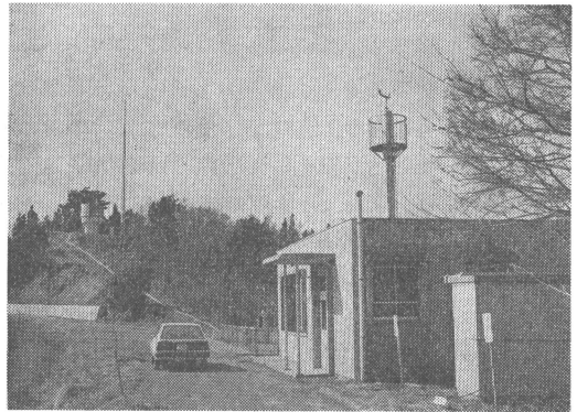
バックグラウンド汚染観測室（写真右手）と CO 2 採取用 20m パンザマスト（写真左手）
