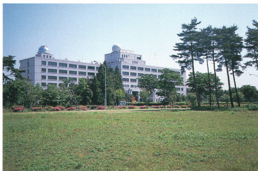
写真1 気象研究所屋上に設置されたレーダ(右)とライダー(左)
