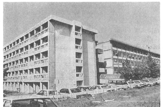
写真1 京大宇治地区 (この建物の中に防災研究所がある)
