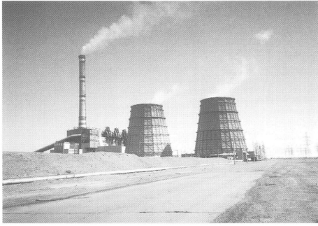
第2図 ウランバートルの火力発電所.
