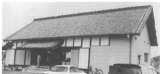
第3図 C地区にあるR寺の北側(上)と南側(下)の屋根の様子。
