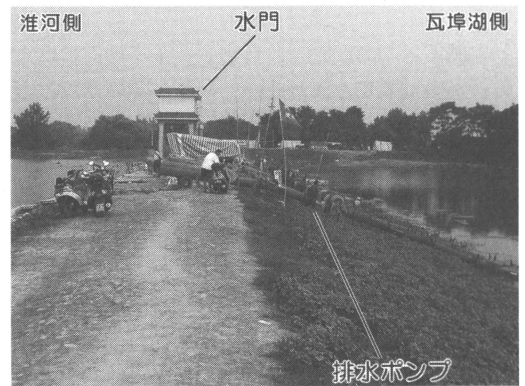
第7図 C地点（第1図bを参照）にある、淮河（左側）と瓦埠湖（右側）とを隔てる水門。淮河の方が水位が高い。堤防上に設置された排水ポンプ（写真中央）は、瓦埠湖の水を淮河へ（つまり右から左へ）送り出すためのものである。
