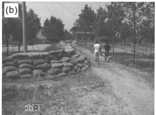
第4図 (a) 堤防爆破が行われた地点から数 km 上流側の堤防(第1図bのA地点). 左側が遊水地で右側が淮河の河川敷である. (b) その近くにある農村集落の様子.
