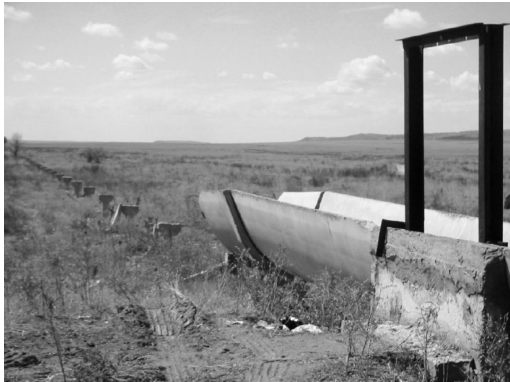
第3図 うち捨てられた灌漑水路(第2図のA付近にて撮影)。
