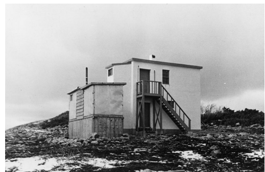
第2図 増築された観測所 (左側) と、完成した本建築の観測所 (右側)。
