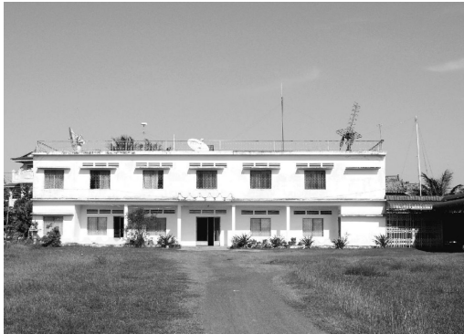
第1図 カンボジア気象局庁舎の全景。屋上の左右には旧ソ連の援助で設置された高層ゾンド受信アンテナがあるが、現在は使われていない。屋上の高いポールと庁舎右側のポールは、SSB無線用アンテナ。
