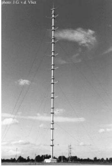
第4図 オランダ Cabauw の213m タワー。風、気温のほかにも視程も観測している。 http://www.knmi.nl/onderzk/atmoond/cabauw/cabauw.html (2010.8.31閲覧)より引用。
