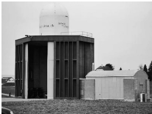
第1図 気球充填庫とゾンデ信号受信アンテナ。
