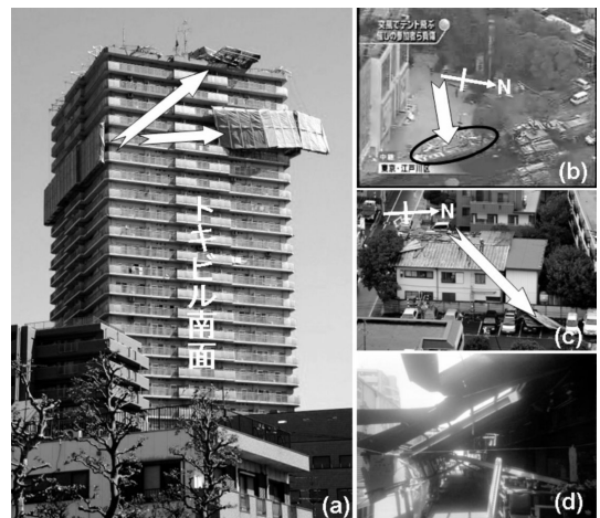
第11図 被害写真。(a) 都営新宿線船堀駅の南にあるトキビル南面。工事用のゴンドラが飛ばされている(中谷浩司氏撮影)。(b) トキビルの北にある広場で、飛ばされたtent等が広場東縁に吹き寄せられた様子(フジテレビニュースより)。(c) 同駅近くの民家の屋根が剥がれて飛ばされている(中谷浩司氏撮影)。(d) 浦安魚市場北口商店会の壊れたアーケードの屋根。商店会アーケードの東南東端から西北西を見ている。屋根は南側が落下、梁の北端が落下して右側の店に突き刺さっている。屋根のトタンが剥がれたり北側にめくられたりしている(芳賀富美江氏撮影)。
