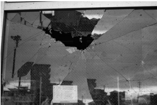
第10図 窓ガラスへの飛来物の衝突痕.
