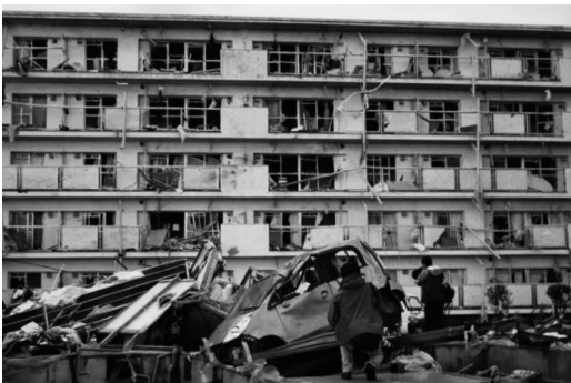
第9図 集合住宅南面の状況.
