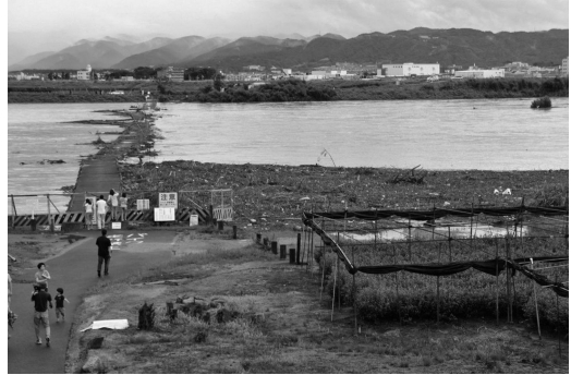
第4図 流失した上津屋橋(流れ橋) (2011年9月4日16時39分 京都府八幡市上津屋).
