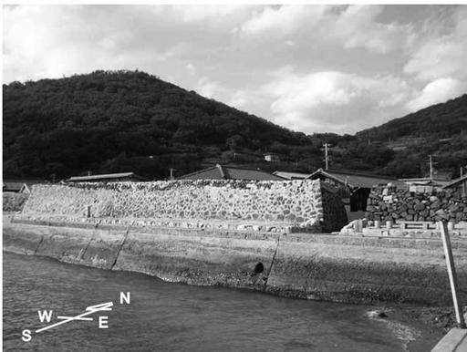
第2図 オーテの例。石積みの高さは4m。第3図の矢印の方向から撮影。
