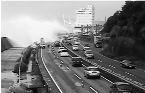
第2図 静岡県内の国道1号での越波のようす。
