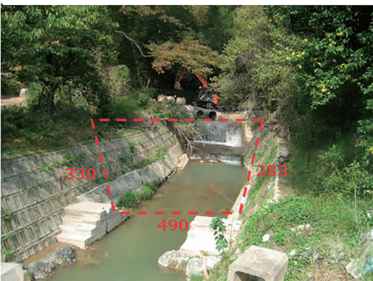
第16図 測量実施時(2014年1月7日)の写真。(a) 前川橋上流、(b) 第三志津川橋上流。赤破線は各ボトルネック部の位置。流出した家屋はa図で前川橋を挟んだ反対側に位置していた。赤数字は実測した各辺の長さ(cm)。
