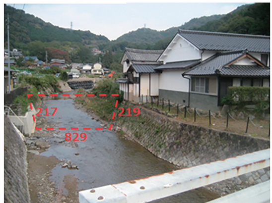
第16図 測量実施時(2014年1月7日)の写真。(a) 前川橋上流、(b) 第三志津川橋上流。赤破線は各ボトルネック部の位置。流出した家屋はa図で前川橋を挟んだ反対側に位置していた。赤数字は実測した各辺の長さ(cm)。
