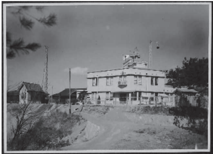
第11図 旧広島地方気象台(現江波山気象館・本館)外観写真(縦11cm×横15cm).
