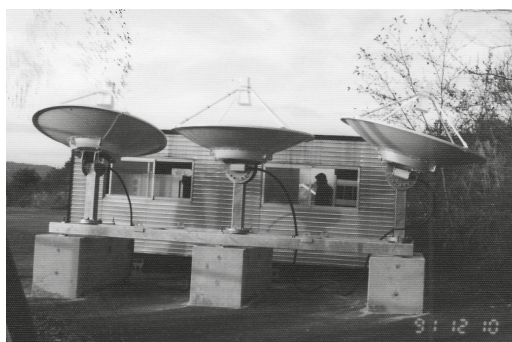
第1図 信楽 MU 観測所に設置された境界層レーダー1号機(1991年12月10日撮影)。
