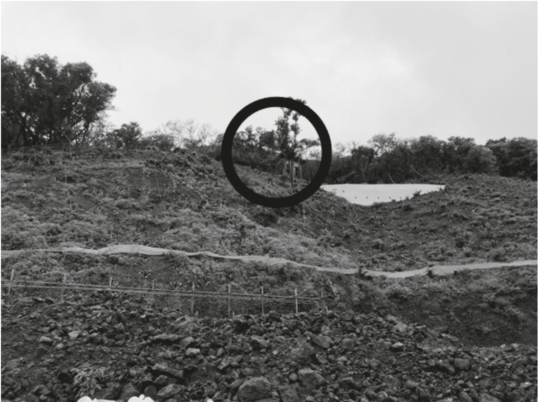
第8図 麓から見上げた母島観測所跡（○で囲った付近）.
