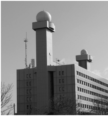
(写真) 更新された仙台ドップラーレーダー 手前の丸いドーム(レドーム)の 中にレーダーが設置されています。
