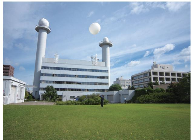
写真2 ラジオゾンデの飛揚。うしろは気象台の入る合同庁舎で、左の塔の天辺のドームの中には気象レーダーのアンテナが格納されている。
