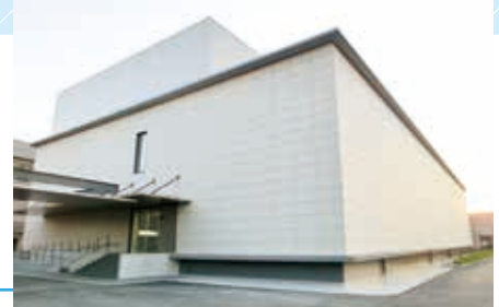
写真1 清瀬第3庁舎写真。計算機専用設計された建屋のため、側面に窓のない怪しい外観です。
